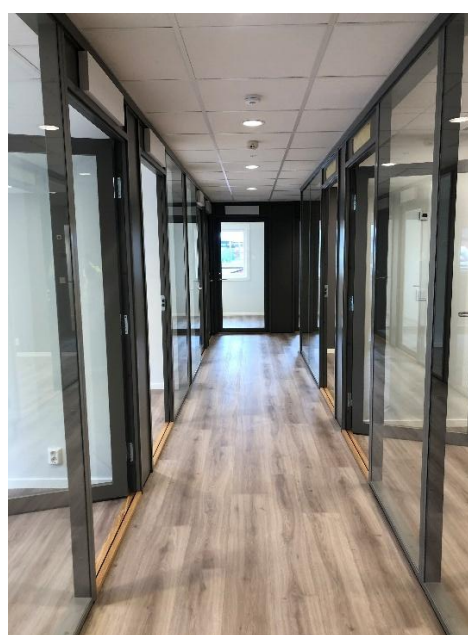
Bilder av eksisterende utførelse av systemvegger i fase 2, 2. etasje. Bilde tatt før foliering ble utført.
